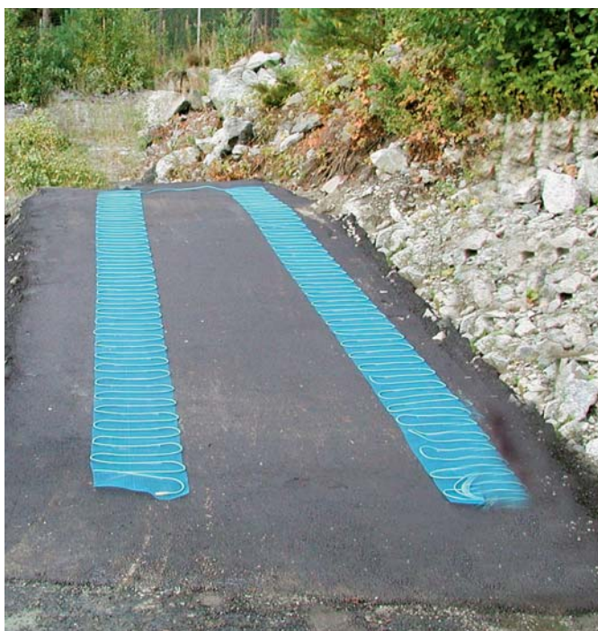
Установка кабельной сетки SNOWMAT
