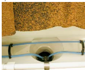
Кабель, уложенный на поверхность крыши
