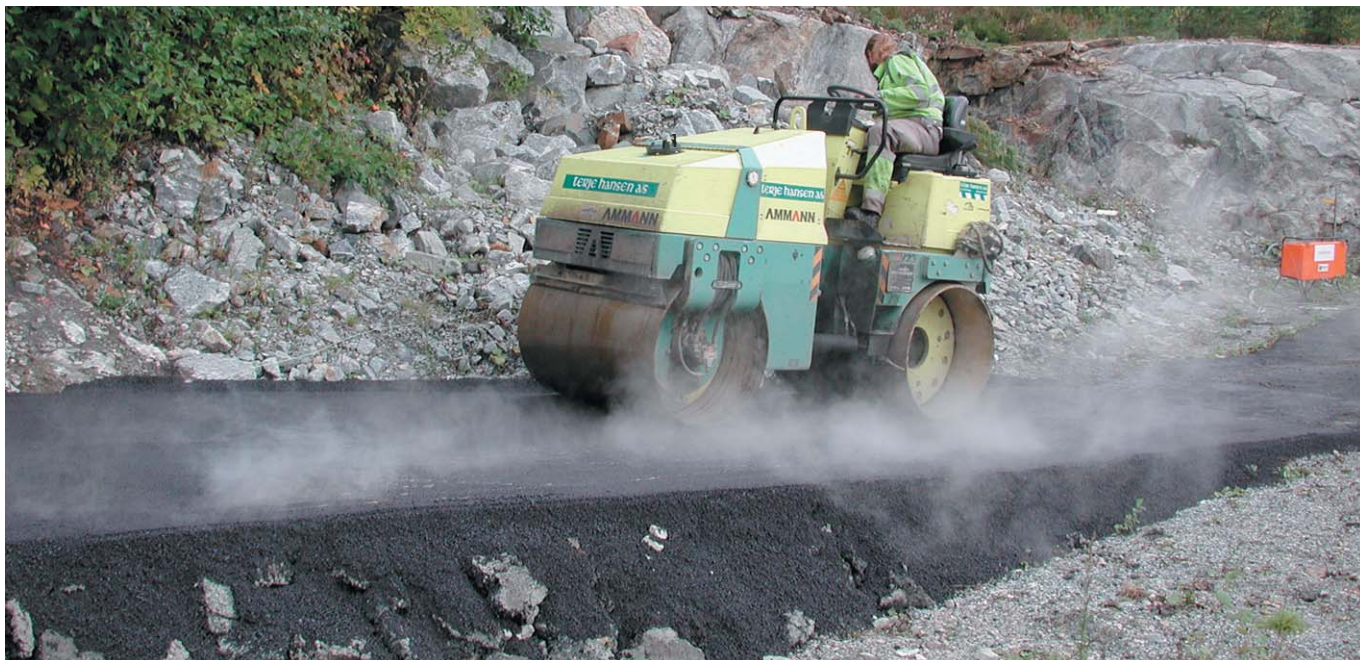
Утрамбовка покрытия после ручной засыпки асфальта
