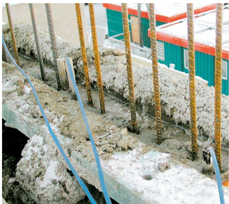
Нагревательный кабель после заливки бетона
